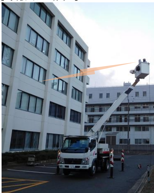
高所作業車を用いて、ローカル5G の電波を建物へ向けて発射
